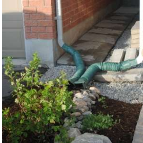
2.kép: esővíz levezető cső leválasztása, az esővíz esőkertbe irányítása
