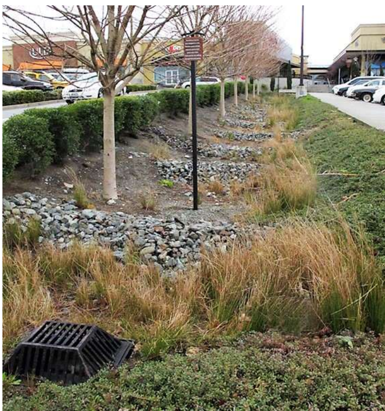
15.kép: keresztgátakkal javított biovápa és fém túlfolyó a rendkívüli csapadékokból származó vízhozam elvezetésére; Northgate Mall parkoló, Seattle. Photo credit: MLSmith
