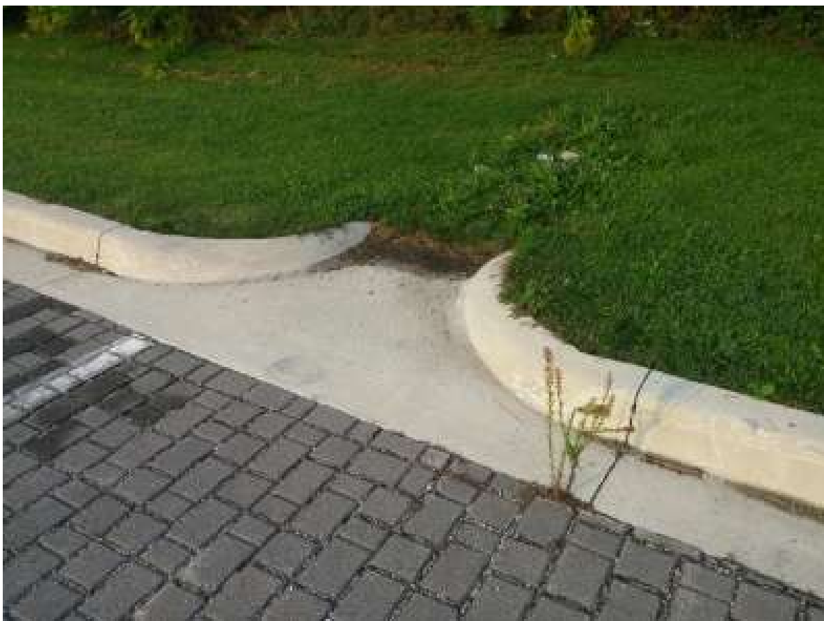
20.kép: surrantós pontszerű bevezetés; a surrantó környezetében lévő növényzet akadályozza a bevezetést
