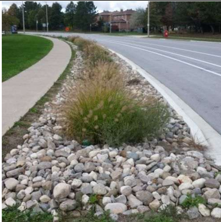
12.kép: biovápa szegélykő megszakításával megoldott bevezetéssel, County Court Boulevard, Brampton
