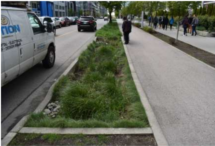
10.kép: szegélykő megszakításával megoldott pontszerű bevezetés, erózióvédelem kőszórással; https://www.climatescan.nl/projects/8228/detail
