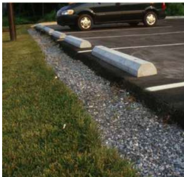
9.kép: kavics elválasztósáv biztosítja az egyenletes, lepelszerű bevezetést
