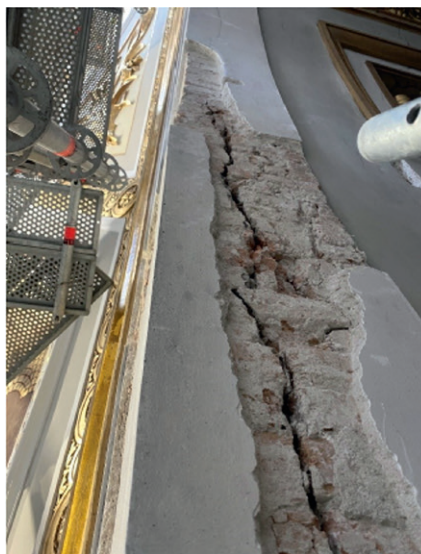
A feltárt kritikus repedések a bazilika padlószintjétől mért +20 m magasságban
