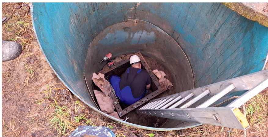
Horányi elosztóakna: tisztítóidom kiszerelése
