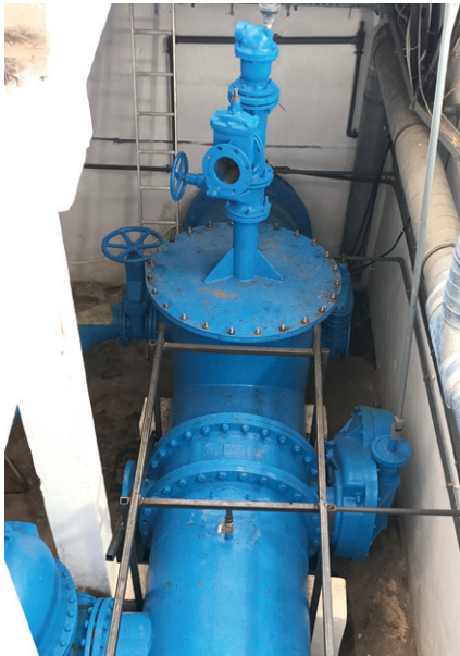
A surányi nyomásfokozó gépházban fémkeret telepítése
