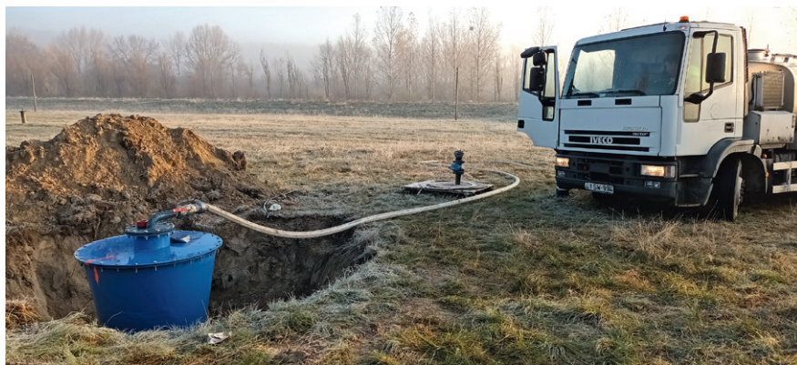
Első szakasz: láncos tisztítóidom behelyezve, mosóautó-kapcsolat rögzítve
