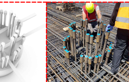
Pászmaátvezetés nagy teherbírású, sűrűn vasalt kör oszlopon
