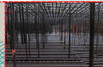
Torony lemezalap vasalása, vasszerelése
