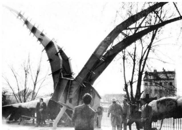
A szobor új acélváza a leburkolás előtt (Forrás: Csöke Sándor)
