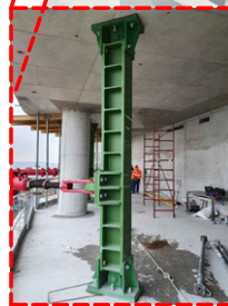
160 m magas toronydarú kikötő szerelvénye
