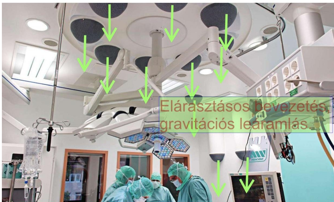
12. ábra TcAF rendszerű levegő bevezetés a műtőbe.
