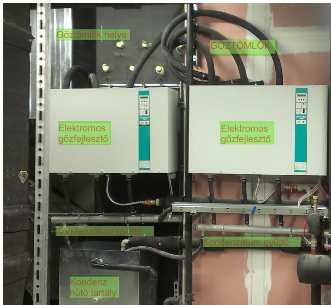
42. ábra Elektromos gőznedvesítő beépítve
