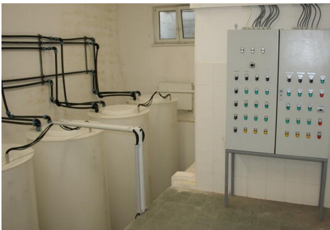
9. kép: Radioaktív szennyvíz inaktíváló rendszer
