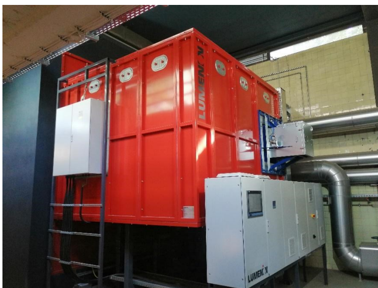
45. ábra. A magas hőmérsékletű hőtárolás megvalósítása egy berlini lakóövezetben [saját készítésű fotó]
