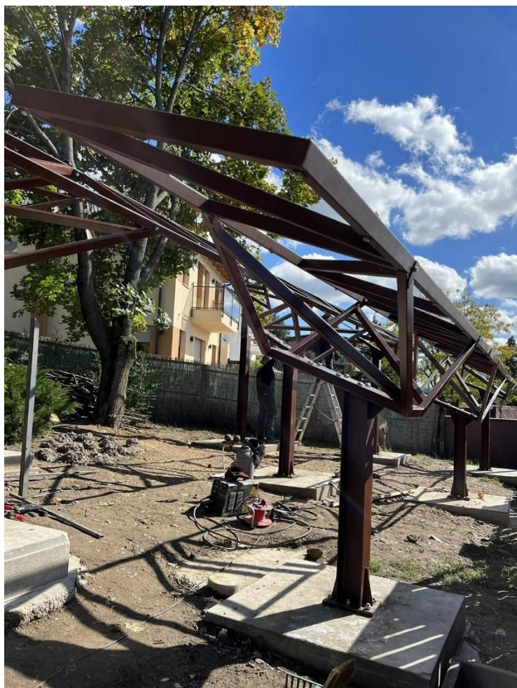
48. ábra Kivitelezés - napelem tartóoszlop [saját készítésű]
