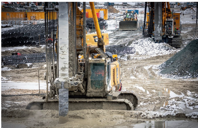
7. ábra: Előtérben az 5. blokk munkagödre, háttérben a 6. blokki talajszilárdítás
