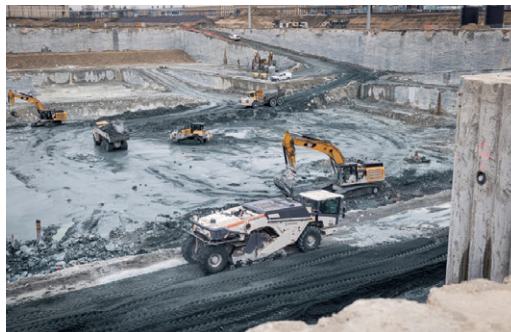
11. ábra: Munkasíkok kialakítása az 5. blokki munkagödörben
