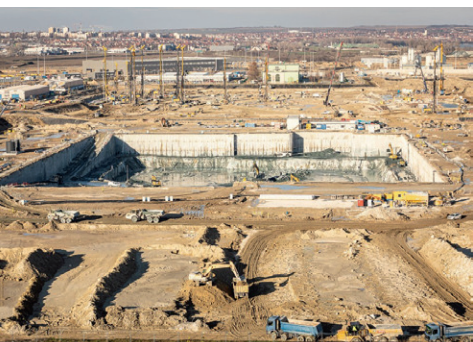
7. ábra: Előtérben az 5. blokk munkagödre, háttérben a 6. blokki talajszilárdítás
