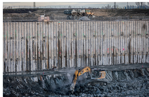
9. ábra: Munka az 5. blokki munkagödörben, hátrahorgonyzott cölöpfal előtt
