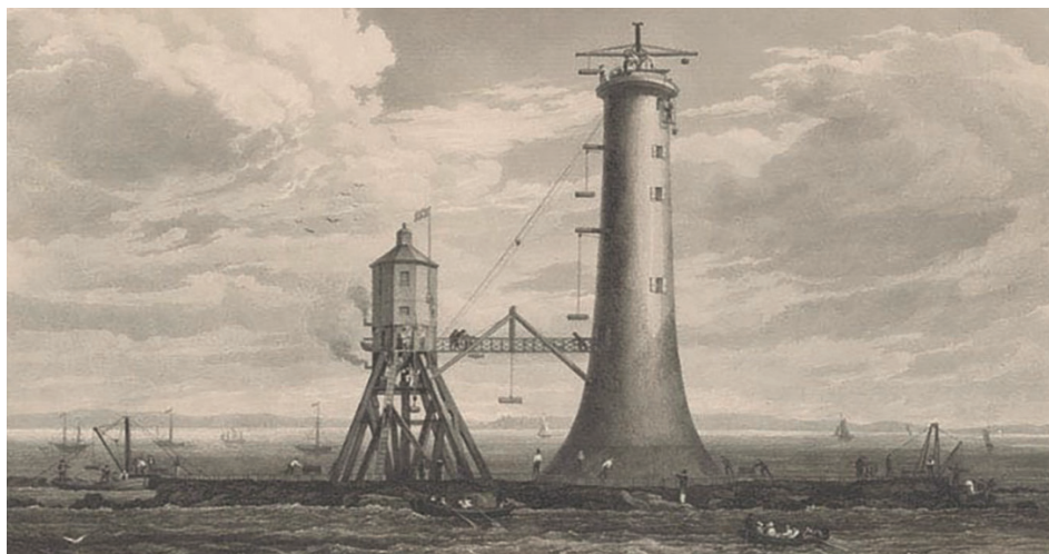
Eddystone építése, balra a segédtorony 2
