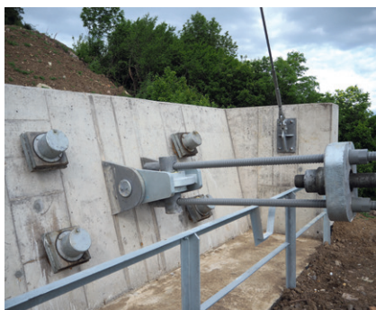
4. ábra A főszélkábél ún. dupla csuklós egyedi be-kötőszerelvénye
