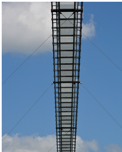
2/b ábra Az ún. normál („N”) és az egymást keresztező („X” rendszerű) mellékszélkáberek vezetése
