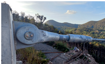
9/a ábra Az első bekötött főkábelfej
