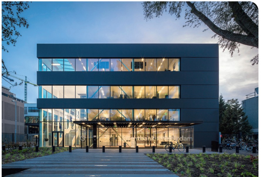
Az ideiglenes törvényszéki épület és a földem építése 4
