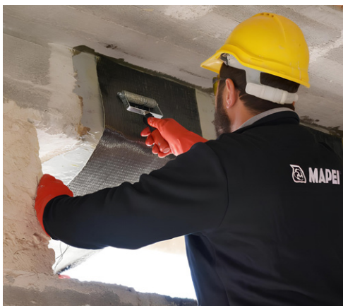
Carboplate lamellák alkalmazása
