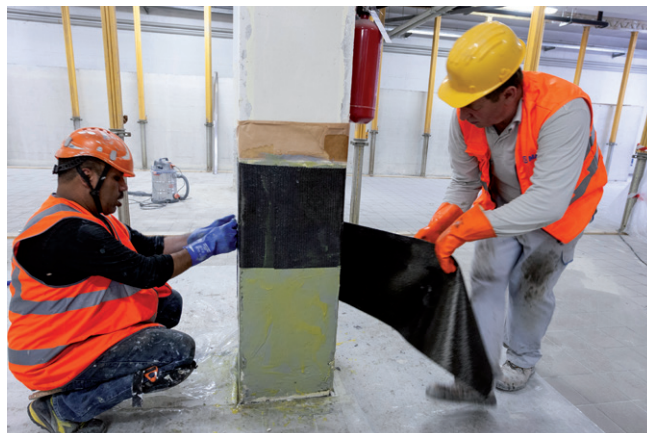
Mapewrap szövet alkalmazása
