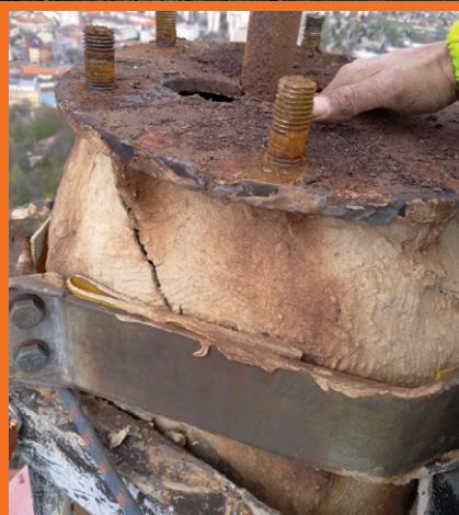
A vb. toronytörzs és az acéltű csavaros kapcsolata
