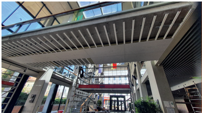
1. kép: Álmennyezet építése a híd alatt (Fotó: Semmelweis Egyetem EOK)
