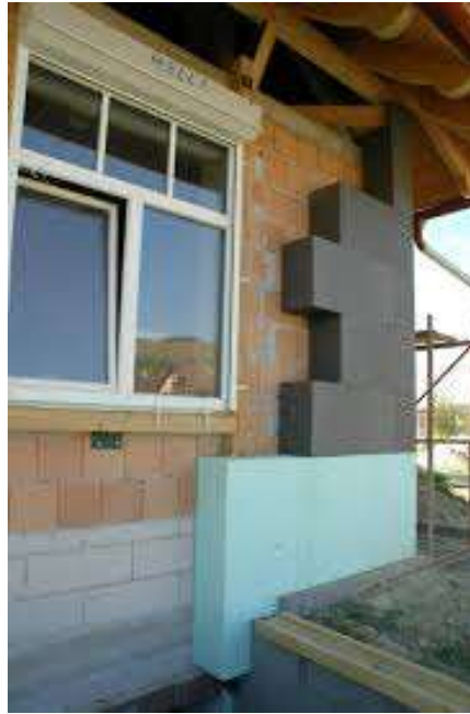
7-1. kép. Homlokzati hőszigetelés [18]
