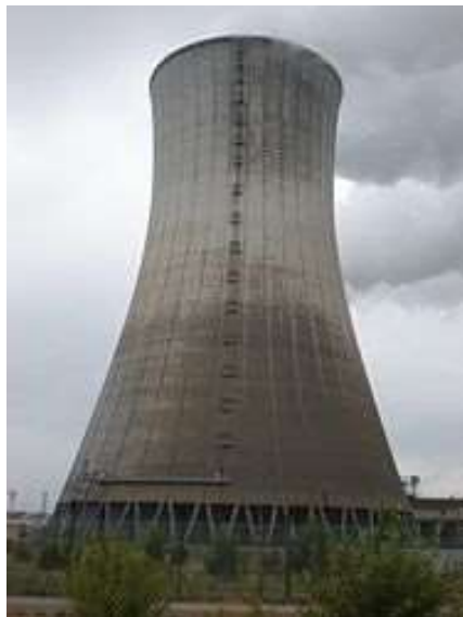
3-3. kép. Heller–Forgó-féle 9 hűtőtorony a franciaországi Tricastin atomerőművében [42]
