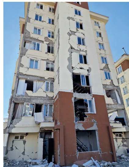
Jellemző épületkár Kahramanmaraşban: sérült és kiesett kitöltőfalak, képlékeny csuklóvá alakult gerendavégek
