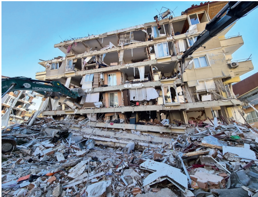
Egy részben összedőlt, megdőlt épület ideiglenes megtámasztásokkal
