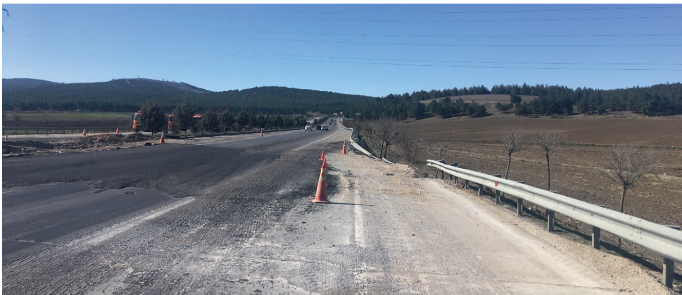
Az Arábiai- és Anatóliai-lemez megcsúszása hatására a D835 számú autópálya sérülése: a lemezek egymáshoz képesti elmozdulása itt 3,6 m
