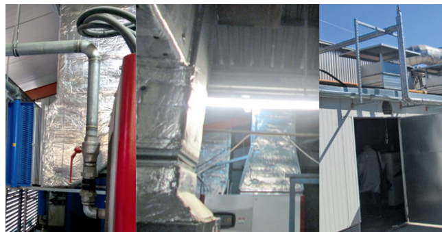
2. kép: A hűtőlevegő beszívása, majd szabadba engedése
