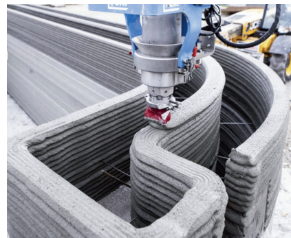
A nyomtatófej kialakításától függ a rétegek felületi megjelenése (Forrás: COBOD, PERI)
