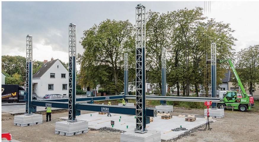
A BOD2 nyomtató a helyszínen (Forrás: PERI)
