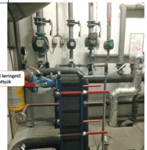
3. ábra: A hőátadásra telepített hőcserélő
