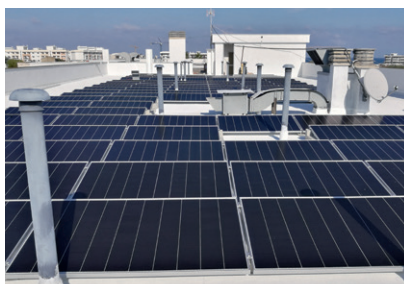
Nagy fényvisszaverő képességű lapostető-szigetelés, napelemrendszerrel
