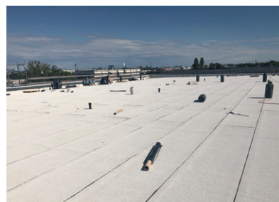
Bitumenes lapostető-szigetelés fehér színű palaörményes lemezzel
