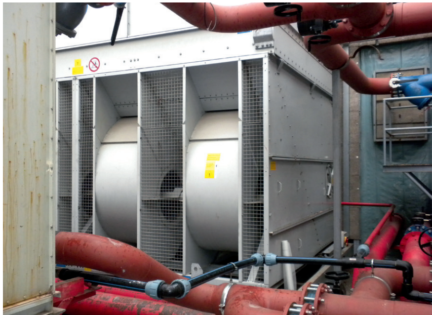
Zártrendszerű lágyított és kezelt víz permetezézéses hűtőtorony
