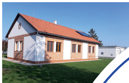
A gátörtelep főépülete a munkáspihenő épületével
