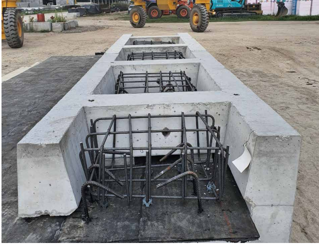
6. ábra: A hídszegély prototípuselemek a betonozás előtt
