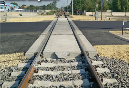
Betonacél nélküli vasúti sínpanel
