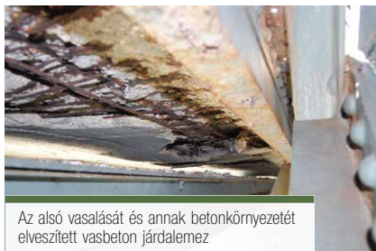
A korrodált betonacélok, átázott beton pályalemez és a szilárdságvizsgálathoz kivett minta helye
