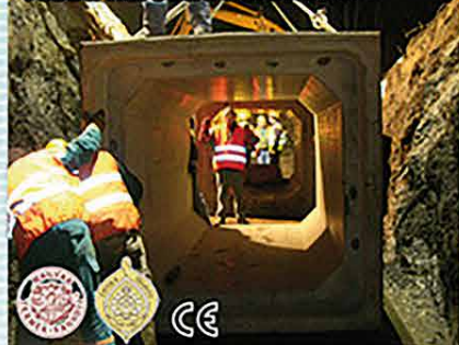
Vasúti kerethíd keretelem (1)
