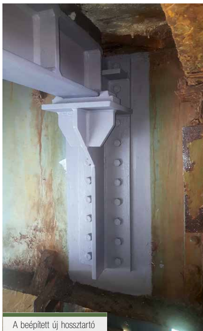
A beépített új hossztartó
