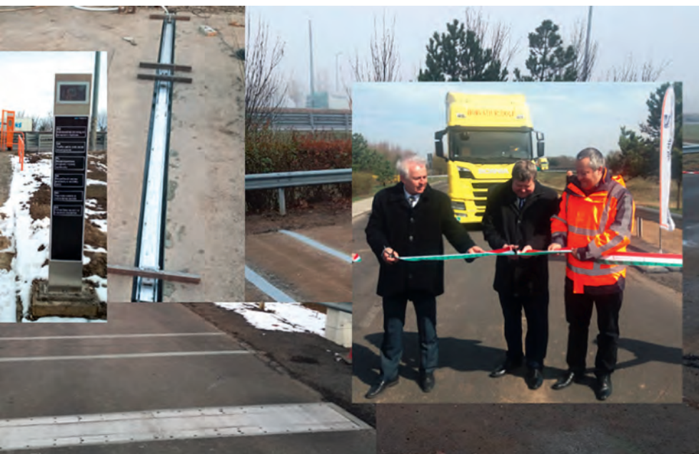
Kísérleti útépités keretében megvalósított, automata össztömeg- és tengelysúly-ellenőrző létesítmény az M30 autópálya mellett (bal pálya, Hejőkeresztúri pihenőhely, forrás: MK NZrt.)
