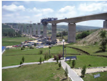
Köröshegyi völgyhíd, építés közbeni állapot
