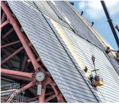
8. ábra. A külső héj szerelése
